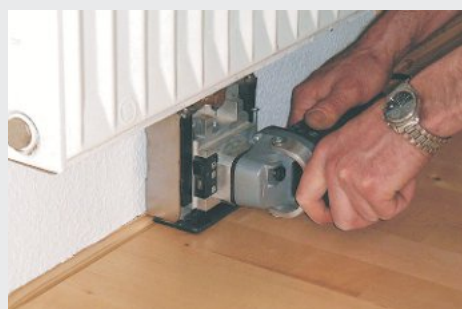
Řezání dilatačních spár pod radiátory
